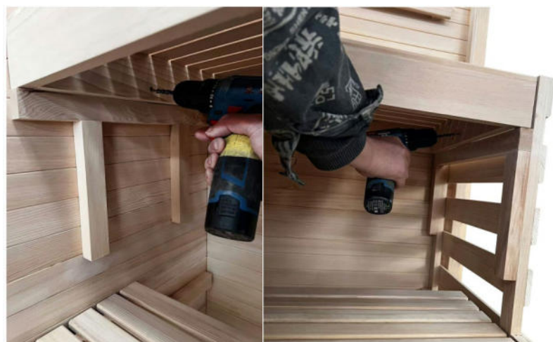
(8) Z vijaki pritrdite levo in desno stran pod klopjo, glejte zgornje fotografije, uporabite vijake 4x50 mm.
