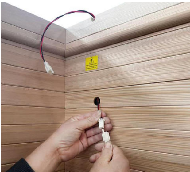
(9) Saunalichtkabel wie oben anschließen.
