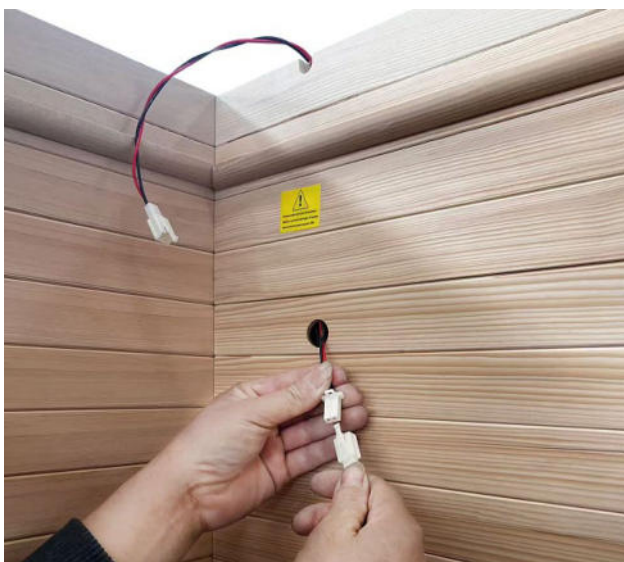
(9) Priključite kabel za razsvetljavo v savni kot je prikazano na sliki.
