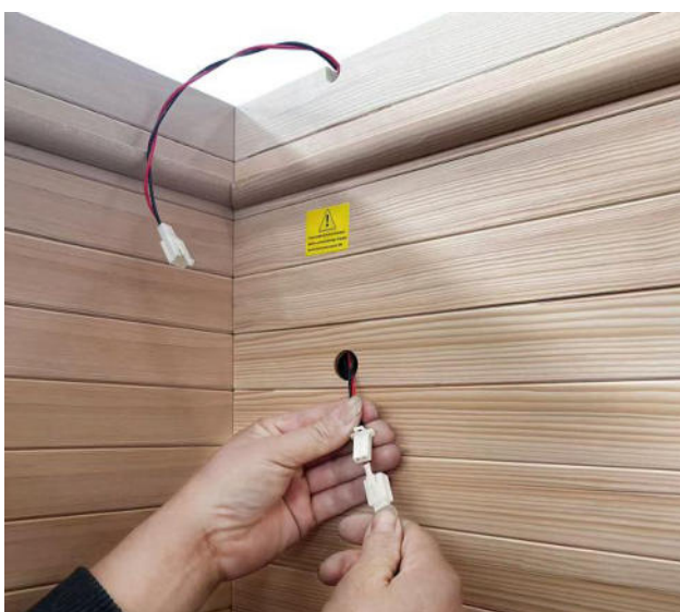
(9) Připojte kabel saunového světla podle výše.
