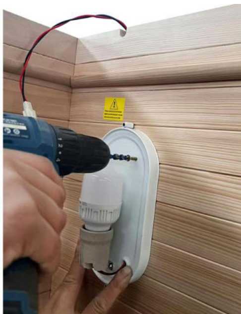
(10) Pomocí šroubováku připevněte kryt světla do sauny (šrouby 3,5 x 25 mm, 2 kusy)
