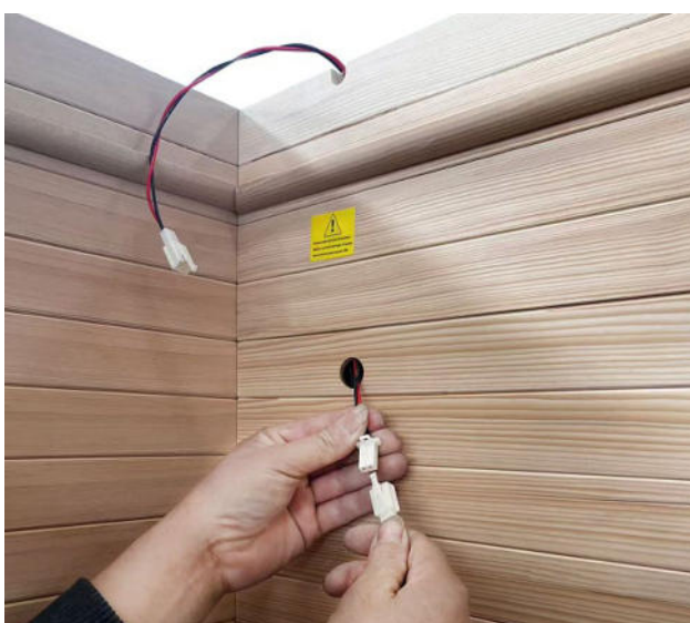
(9) Spojite kabel za rasvjetu saune kao što je prikazano na slici.
