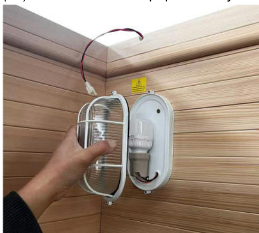
(11) Nainštalujte vodotesný kryt saunového svetla (skrutky 4x12 mm)
