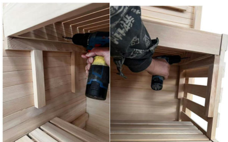
(8) Pomocou skrutiek pripevnite ľavú a pravú stranu pod lavicu (pozri fotografie) (skrutky 4x50 mm)
