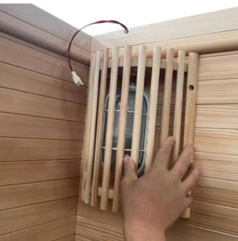
(12) Montieren Sie die Holzabdeckung für das Saunalicht (3x25mm Schrauben 8 Stück)
