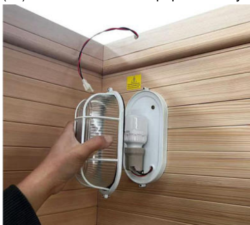
(11) Nainstalujte vodotěsný kryt světla do sauny (šrouby 4x12 mm)
