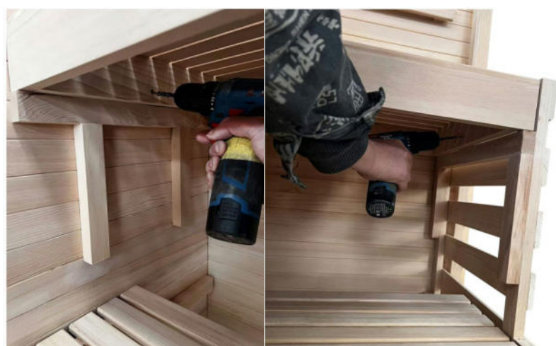
(8) Pričvrstite lijevu i desnu stranu ispod klupe vijcima, pogledajte fotografije iznad, koristite vijke 4x50 mm.
