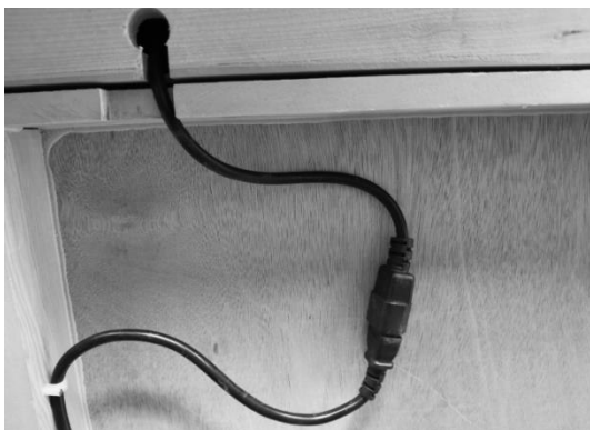
(1) (1) Zasuňte zástrčky topných kabelů (ujistěte se, přiskřípnuty stropním panelem nebo jinými. (2) Zapojte konektor ovládacího kabelu.
