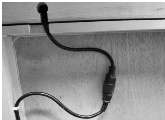
(1) Conectați cablurile panourilor de încălzire, Asigurați-va că, cablurile nu sunt prinse între panoul capac și alte panouri.
