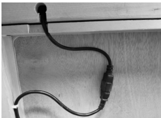
(1) Включете конекторите на нагревателните кабели, уверете се, че кабелите не са притиснати между панела на тавана и други панели.
