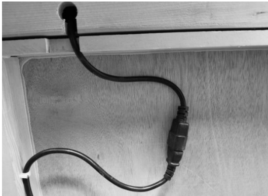
(1) Stecken Sie die Steckverbinder der Heizkabel ein, stellen Sie sicher, dass die Kabel nicht eingeklemmt Deckenpaneel und anderen Paneelen.
