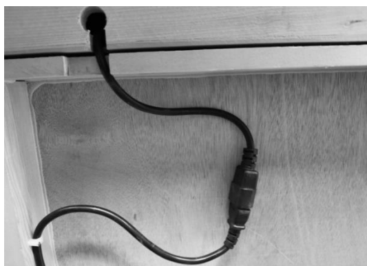
(1) Zapojte zástrčky topných kabelů, (2) Zapojte zástrčku ovládacích kabelů. Zkontrolujte, zda kabely nejsou uvíznuté mezi
