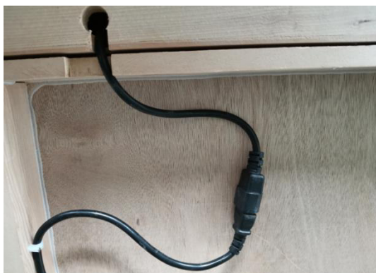
(1) Priključite konektorje kablov grelca, prepričajte se, da kabli niso ujeti med stropnim panelom in ostalimi paneli
